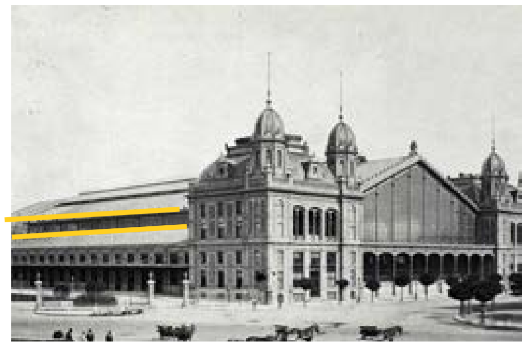
Az Eifel Csarnok tetején található nagyvonalú üvegezési csíkok természetes fényt engednek be a nagy fedett térbe.
